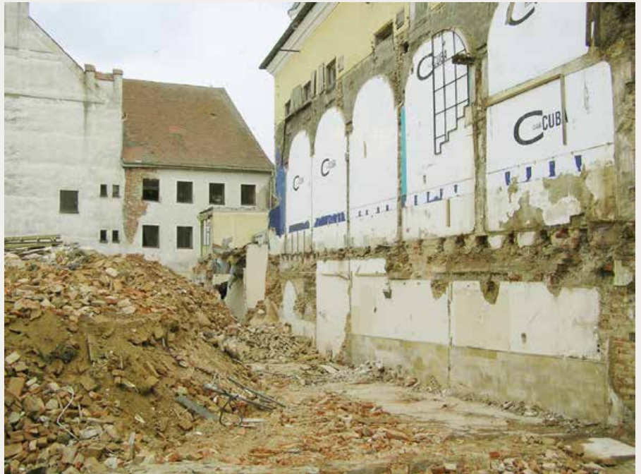
Abbruch Griesbacher Str. 2 i.Jahr2017
