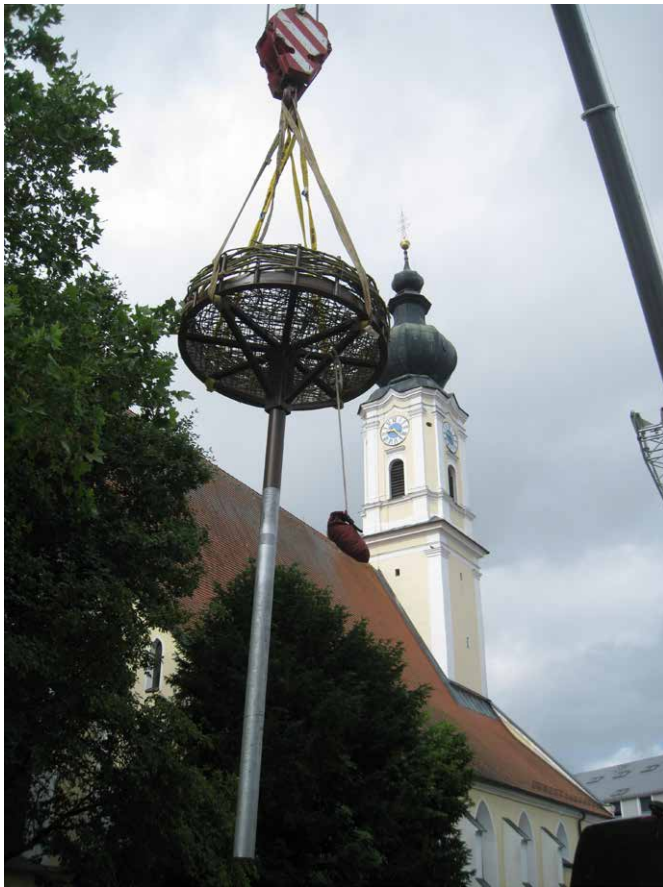
Der Nistkorb wird vom Kran hochgehoben.
