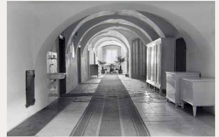
Tonnengewölbe im 1. OG d.Gasthofes
