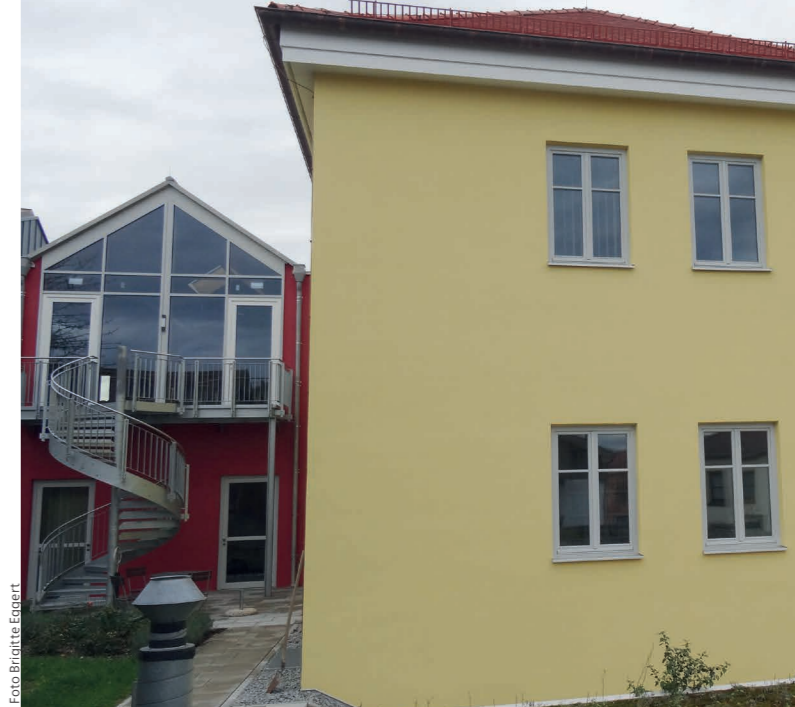
Rathuserweiterung Ostseite - ehemaliges "Brodingner-Haus" mit Fluchttreppe vom neuen Sitzungssaal im ersten Stock
