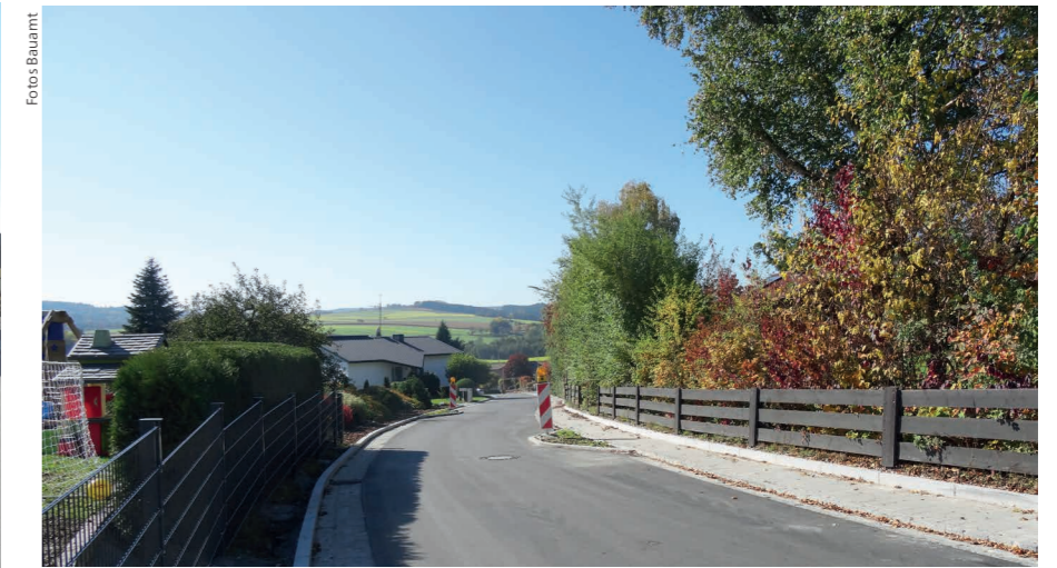
Straßenbau in Pattenham
