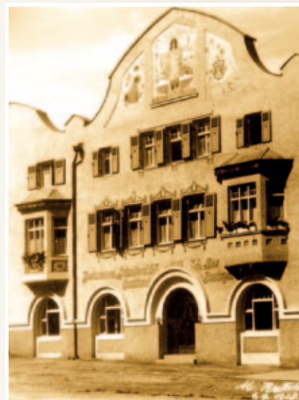
Marktplatz 35 im Jahre 1908 nach dem Umbau
