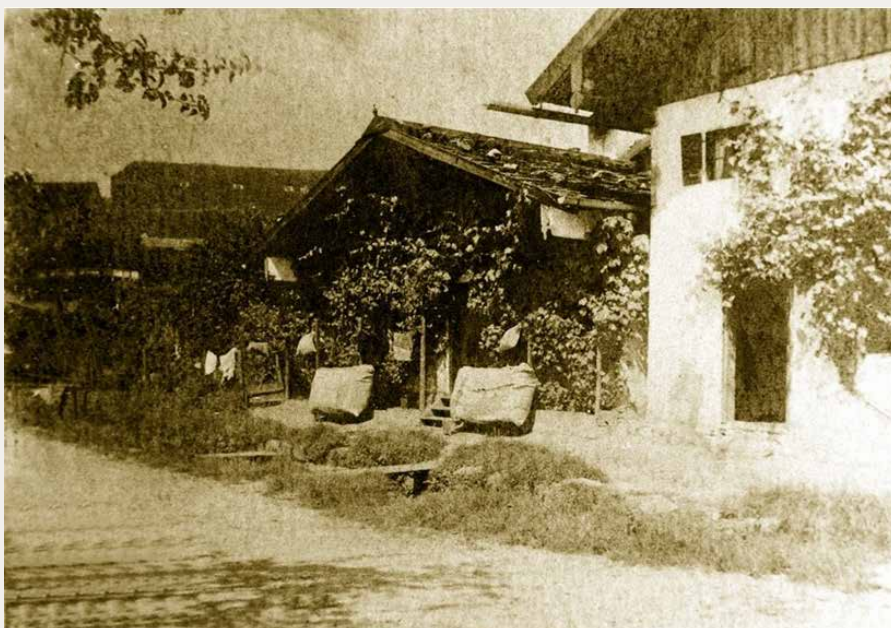
Das ehem. Färbhaus Unterer Markt 10 um 1890 (jetzt Auer Karl)
