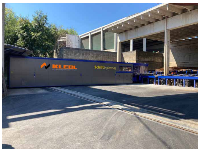
Mess- und Schneidwagen neben Stahllager
