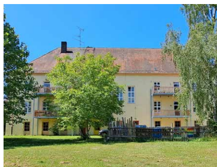
Auf der Rückseite wurden Balkone neu angebaut.
