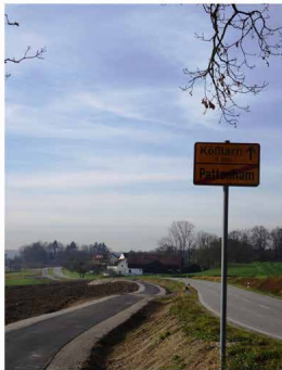
Beispielfoto Radweg Rotthalmünster-Köblam
